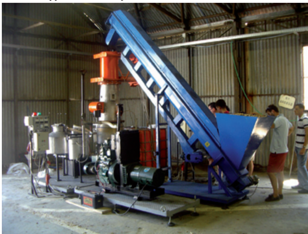
Impianto di gassificazione a letto fluido presso i laboratori di Savona dell'Università degli studi di Genova
